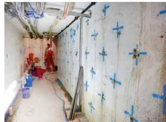
Bild 7: Die Injektionsstellen wurden untereinander horizontal versetzt angeordnet, um eine Überschneidung der einzelnen Injektionskörper zu erreichen. (Quelle: TPH.)
