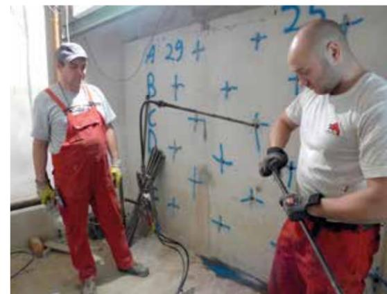
Bild 8: Rammlanzen werden mittels Gewinde miteinander verbunden. Der Injektionsstoff drang durch die ca. 4mm grossen Öffnungen in den Baugrund und penetrierte diesen. (Quelle: TPH.)
